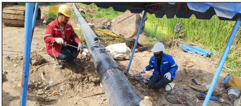
การตรวจสอบรอยเชื่อม (Radiographic Testing)
