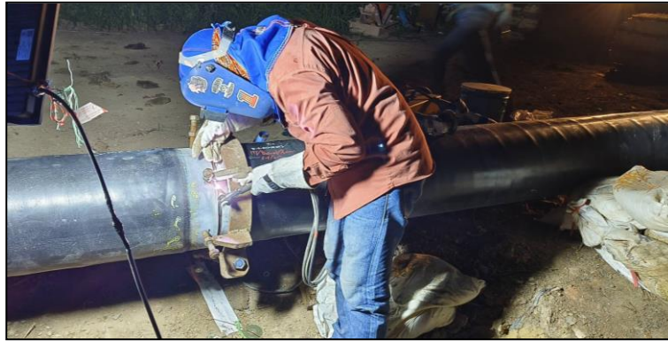
การเชื่อมท่อส่งน้ำมัน (Welding)
