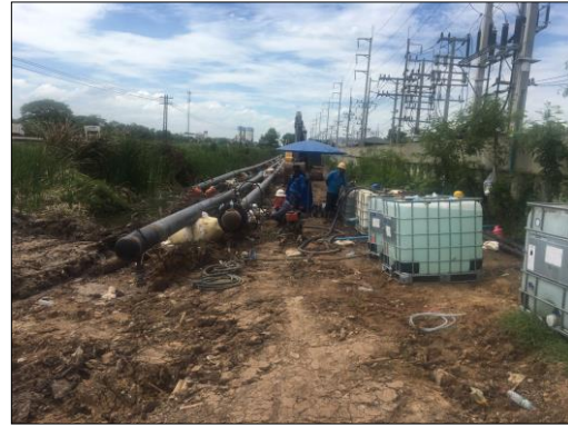
การเชื่อมท่อส่งน้ำมัน (Welding)
